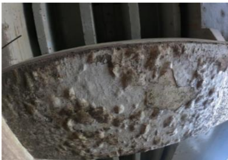
Figura 3 – Detalhe da pintura com deficiência de aderência – Berço 105
